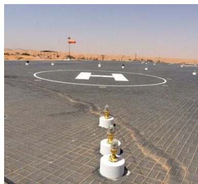
Heliport na poušti
